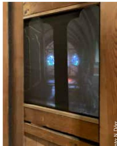
Blick aus dem Schwellwerk 2 im Orgelinneren in die Kirche: Die restaurierten Schallöffnungen sind wie einst wieder mit Stoff bespannt, statt mit Sperrholz verschlossen, so dass feine Klänge gut zu hören sind.
