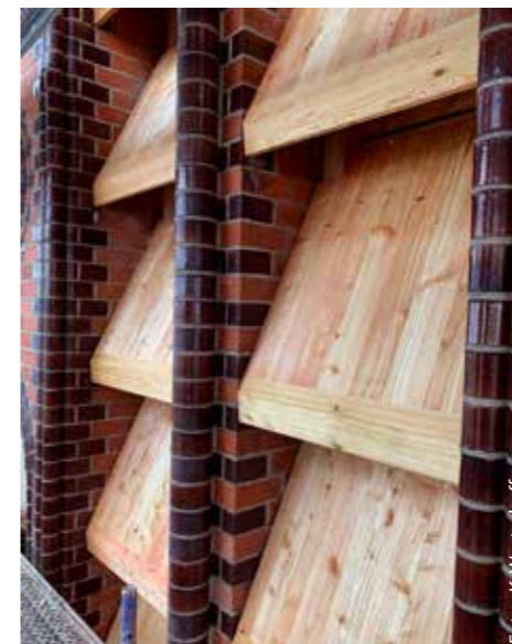
Die Schallluken, aus noch unverwittertem Lärchenholz
