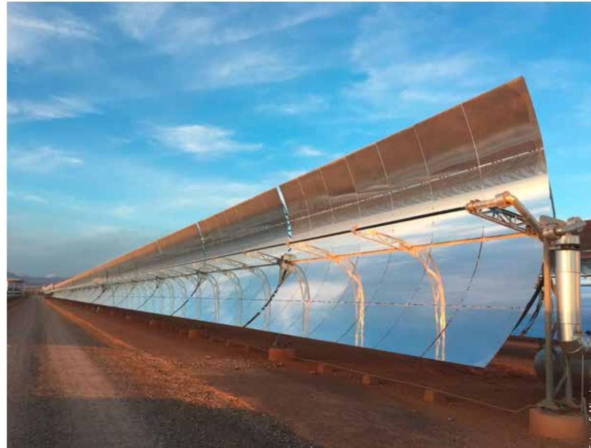
Hier sieht man einige der 537.000 (!) Parabolspiegel der Anlage in Quarzazate im Inland von Marokko. Sie stehen in 400 Reihen, die je 300 Meter lang sind, und erwärmen synthetisches Öl auf 400 Grad Celsius.
