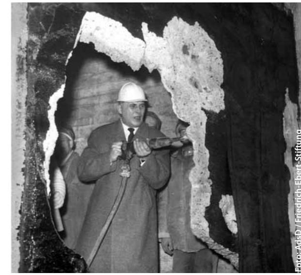
Der Mann legt selber Hand an: Rolf Schwedler beim U-Bahn-Durchstich an der Buschkrugbrücke im Juni 1962.
