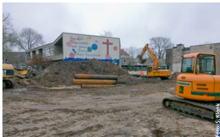
Vom Chaos zum Tummelplatz. Die Bauarbeiten für das Bildungszentrum beginnen.
