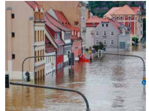
Die Stadt Meißen hat mehrfach unter Hochwasser der Elbe gelitten, in den Jahren 2002 und 2013 standen die Wasserpegel besonders hoch. Ein kleiner Seitenarm der Elbe, die Triebisch, hatte 2002 zusätzlich verheerende Schäden angerichtet. Wochenlang war die Stadt im Chaos versunken.
